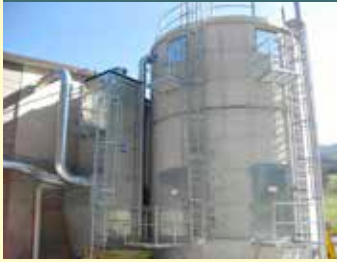
«Wolf» – Silo mit Austragung und untergebauter Heizung
