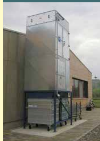
Hacker LR 700 Drucklose Schnitzelbefüllung
