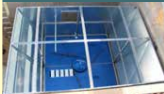
Anlage eingebaut in Gebäude mit Druckentlastung durch die Aussenwand Baujahr 2014
