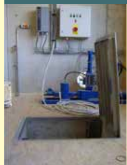
Hacker LR 700 Drucklose Schnitzelbefüllung
