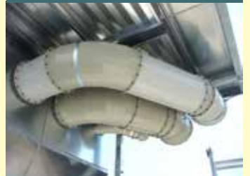
Anlage eingebaut in Gebäude mit Druckentlastung durch die Aussenwand Baujahr 2014
