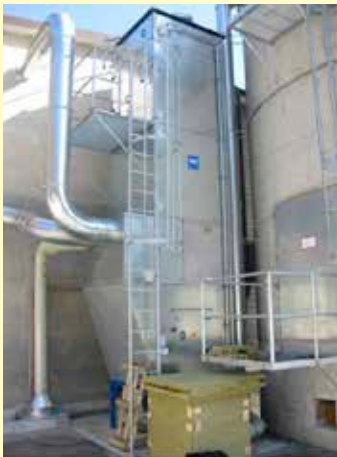
«Wolf» – Silo mit Austragung und untergebauter Heizung
