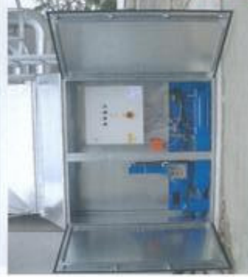
IPE-Filteranlage und Brikkettpresse SP mit Wetterschutzeinrichtung macht die Außenaufstellung problemlos
