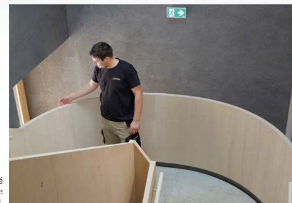
La main courante de l'escalier de la société Rüscher a été fabriquée à l'aide d'une presse à vide BARTH.
