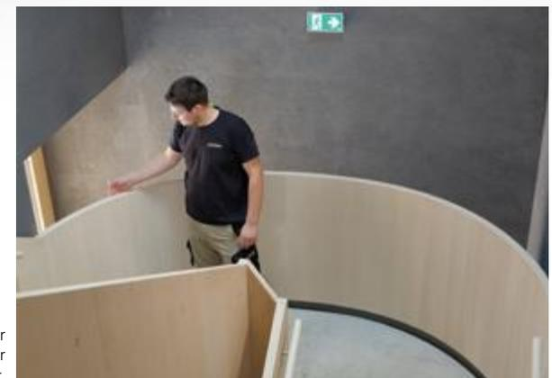
Der Handlauf im Treppenhaus der Firma Rüscher wurde mit einer BARTH Vakuumpresse hergestellt.
