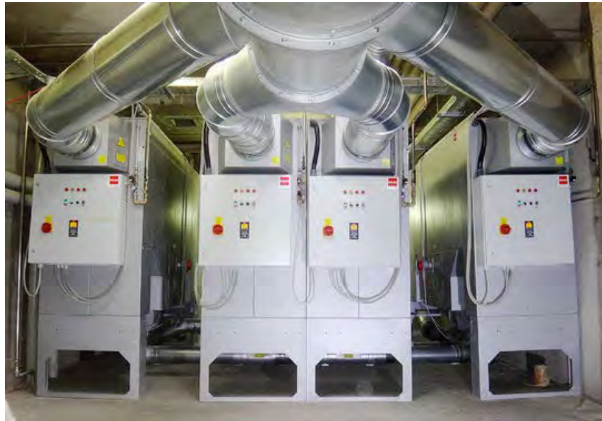
Batterieaufstellung/ Installation en batterie
